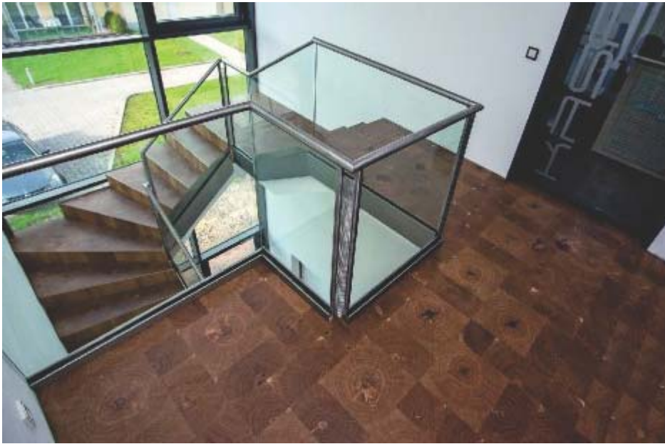
/ Modifiziertes Hirnholz reißt nicht mehr, ist aber immer noch wunderbar druckfest und deshalb ideal geeignet für Treppen und Fußböden.
